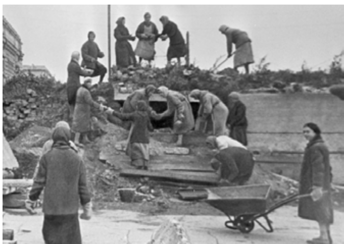
Жители блокадного Ленинграда на строительстве оборонительных сооружений
